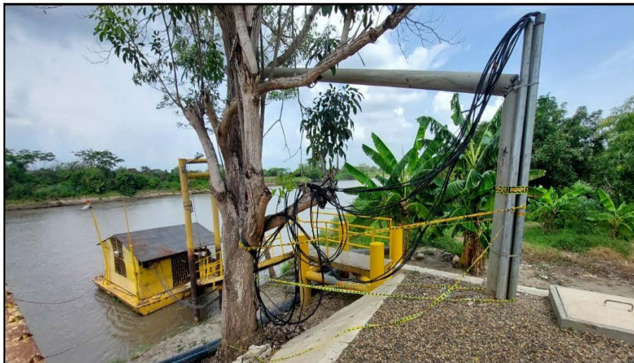
REGISTRO FOTOGRÁFICO 2. REPARACIONES PROVISIONALES AL SISTEMA ELÉCTRICO DE LA BOCATOMA. FECHA: 16 DE MAYO DE 2023.
