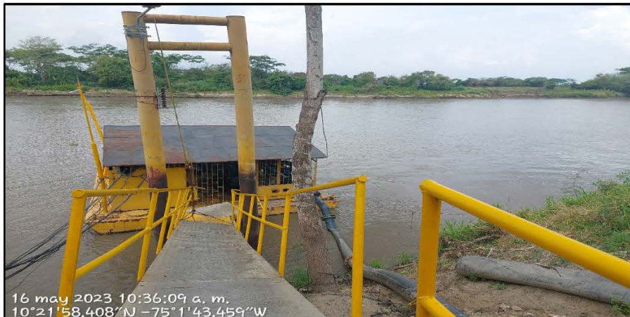
REGISTRO FOTOGRÁFICO 1. BARCAZA FLOTANTE LOCALIZADA EN EL PUNTO ORIGINAL DE CAPTACIÓN. FECHA: 16 DE MAYO DE 2023.
